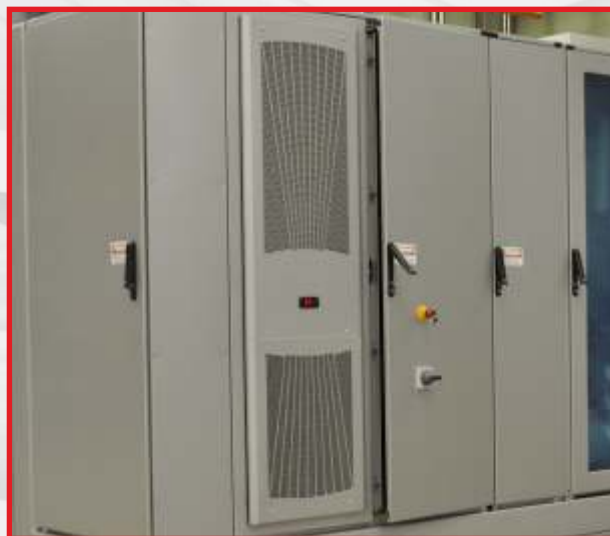
Condizionatore armadio elettrico. Electrical cabinet conditioning system. Schaltschrank-Klimatisierungssystem. Système de climatiseur d'armoire électrique.
